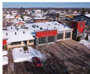
Agrandissement et réaménagement de la caserne pour couverture continue 24h sur 24, 7 jours sur 7
